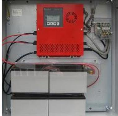
Steuergerät TK1000 mit 4 Batterien
