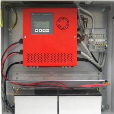
Steuergerät TK250-500-750 mit 2 Batterien
