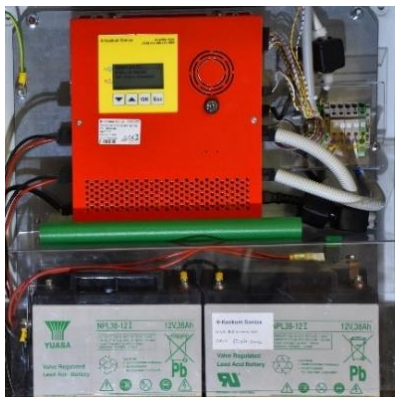
Steuergerät AT-M mit 2 Batterien NPL38-12i
