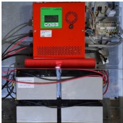
Steuergerät AT mit 4 Batterien NPL24-12i
